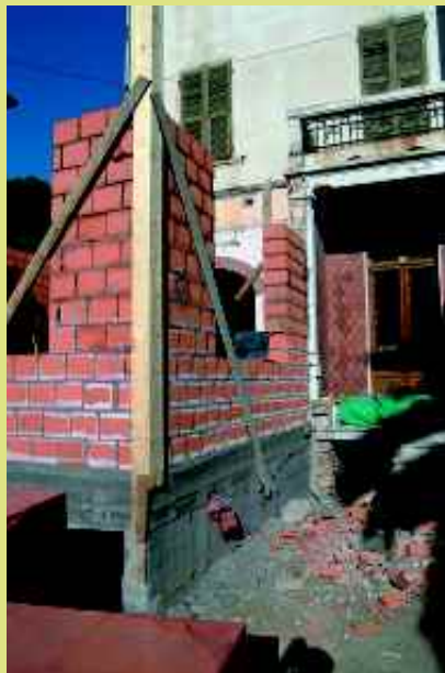
Veduta della parte anteriore della Villa Maria Teresa di Celle Ligure, in ristrutturazione.
